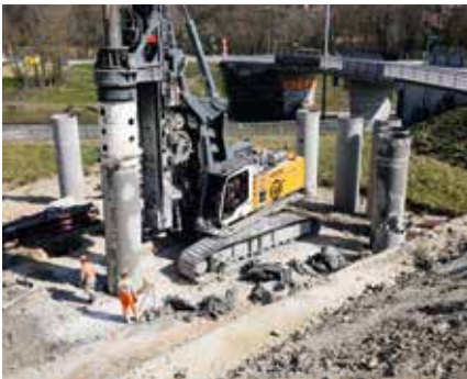
En haut, enjambement de la Venoge. En bas, le forage des pieux, la construction de la route et, à droite, passage inférieur du cimetière.
